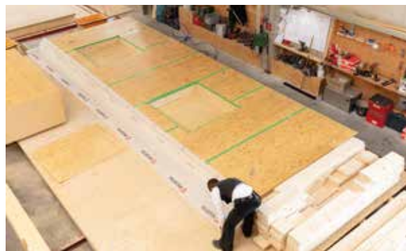
Die Wandelemente wurden auf Montage-tischen zusammengebaut
