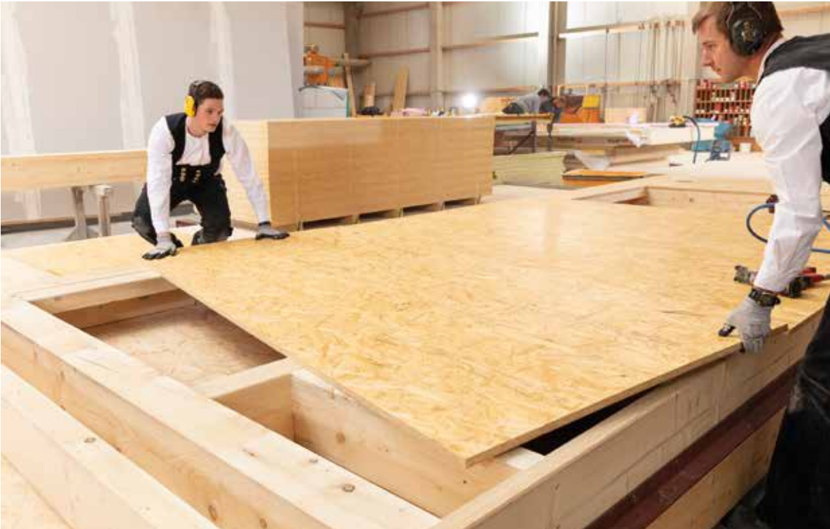
Im Werk wurden die Holzrahmenwände mit OSB/4-Platten von Swiss Krono beplankt
